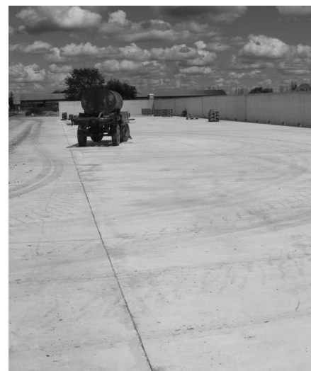
2. ábra Silótároló építés közben
